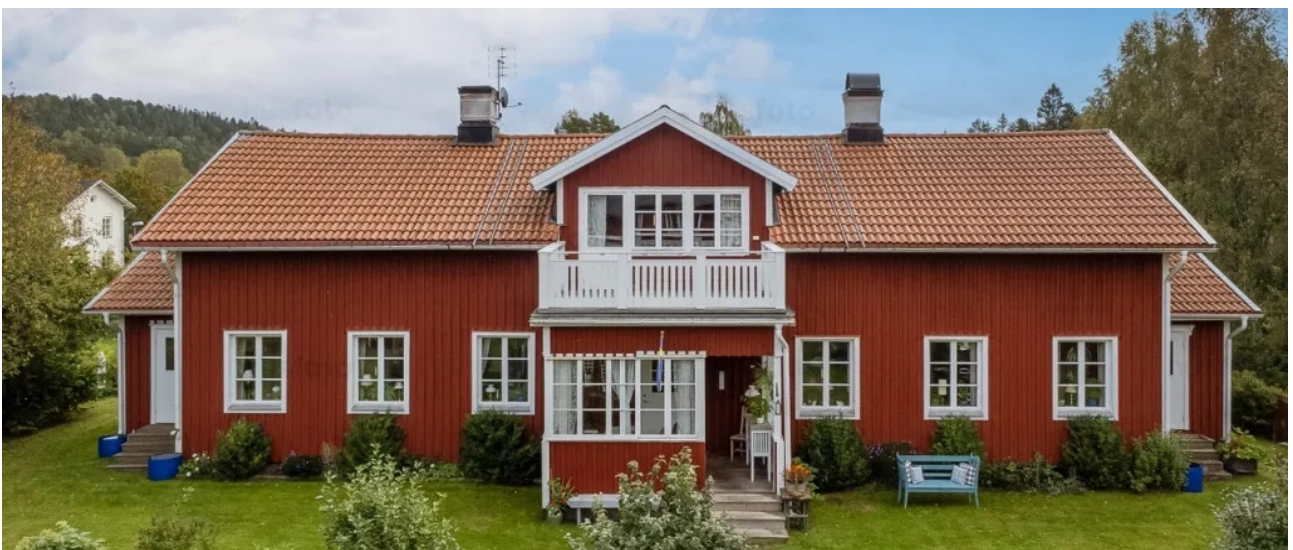
Huset sett framifrån
